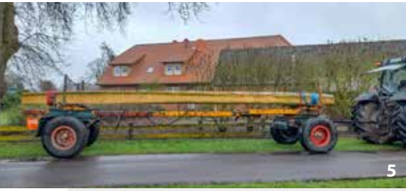
5 Frisch gesägter Überzugbalken bei der Anlieferung (Foto: Bohling, 2023)
