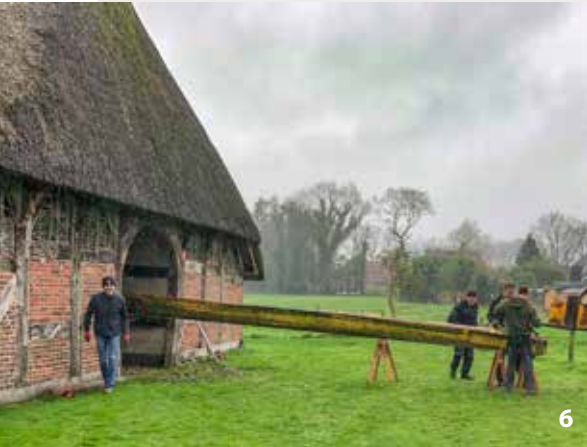
8 Weitertransport des Balkens mit einem Kettenzug (Foto: Bohling, 2023)
