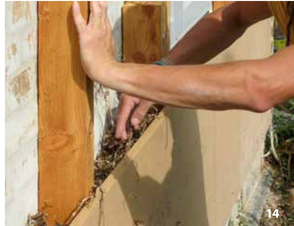
14 Fassadendämmung mit Seegras
