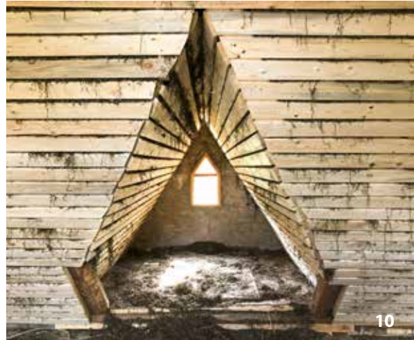
9, 10 Dachschräge mit Seegrasdämmung
