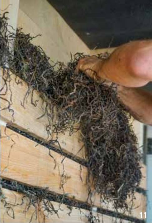
11, 12 Innendämmung mit Seegras und Wandheizung
