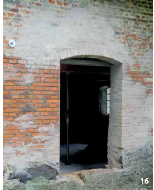
16, 17 Die fertig sanierte Türöffnung aus den Bildern 7 bis 12. Die Innenkante folgt sichtbar der sich nach unten verdickenden Mauerstruktur. Die originale Größe – erkennbar an den Mauerwerkskanten und der Durchlassöffnung im Feldsteinsockel – ist wieder hergestellt
