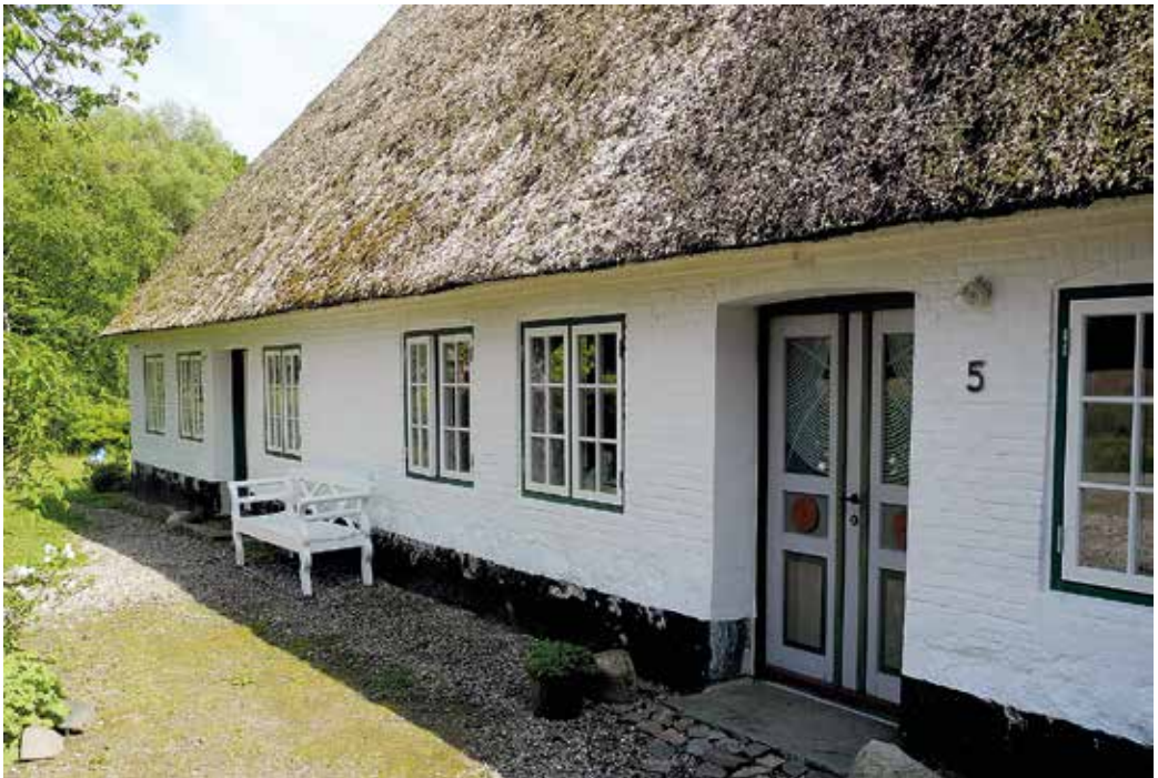
20 Ansicht der Hoffront nach erfolgtem zweiten Anstrich mit Kalkschlämme. Bereits jetzt ist die Farbe nach lang-samer Trocknung und Karbonatisierung vollflächig deckend. Ein Abrieb beim Darüberstreichen findet, ganz anders als bei den ursprünglich am Haus befindlichen Anstrichen, nicht mehr statt. Der schwarze Sockel aus alter Bitumenfarbe ist das nächste „Projekt“
