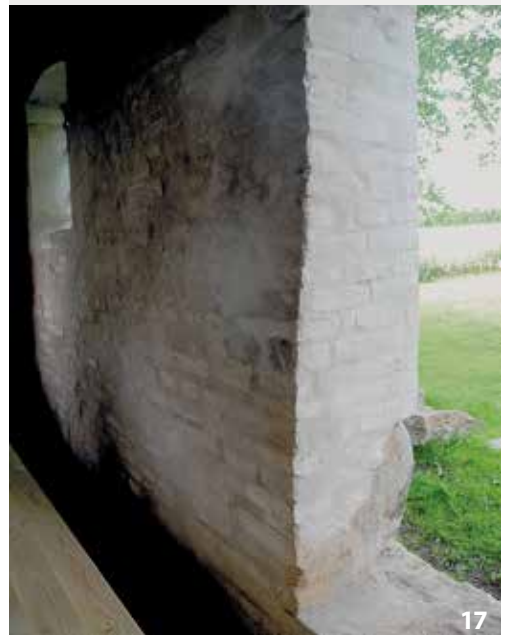
16, 17 Die fertig sanierte Türöffnung aus den Bildern 7 bis 12. Die Innenkante folgt sichtbar der sich nach unten verdickenden Mauerstruktur. Die originale Größe – erkennbar an den Mauerwerkskanten und der Durchlassöffnung im Feldsteinsockel – ist wieder hergestellt
