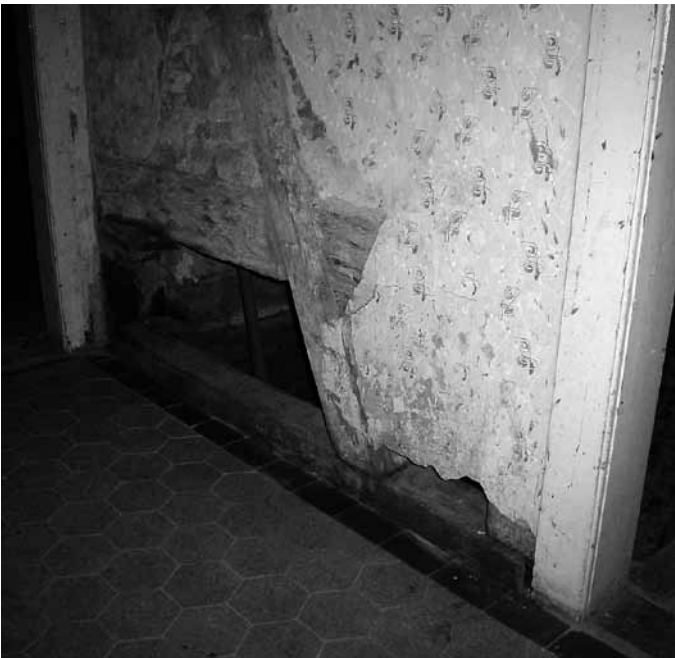
Blick vom Flur auf die neu eingebaute Schwelle.
