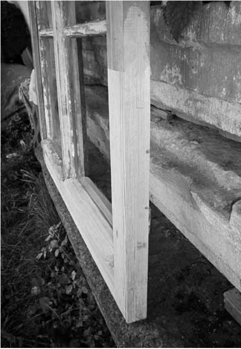
Ein Fenster in der Reparaturphase
