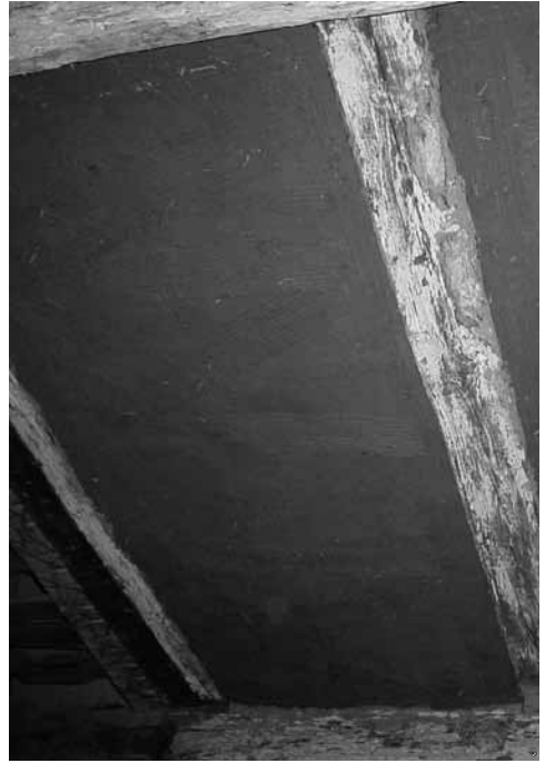
Erneuerte Lehmdecken im Obergeschoss
