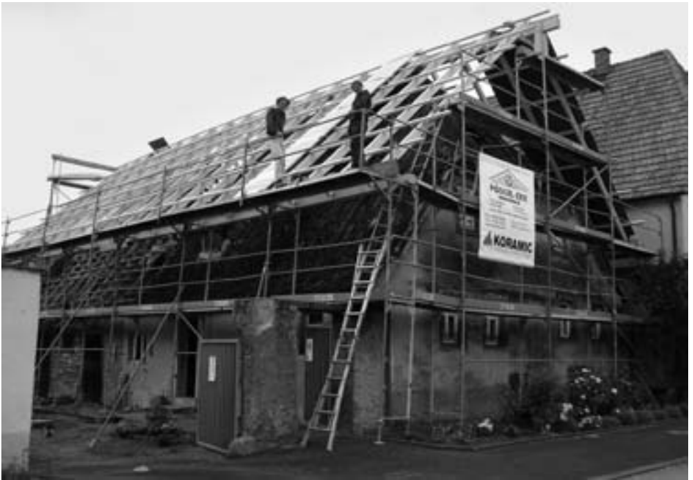
Ein wichtiges Etappenziel ist erreicht – das Notdach konnte im Juni 2009 errichtet werden. Links auf dem Gerüst: der Autor Matthias Braun.
