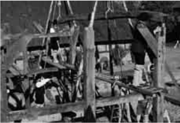
Aufsetzen der Dachbalken (Foto: FLMK)
