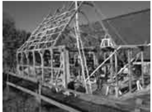
Das fast fertige Gerüst (Foto: FLMK).
