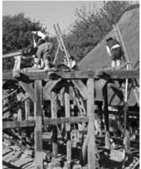
Impressionen von der Baustelle (Foto: FLMK)
