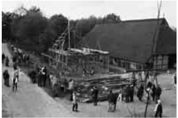
Gesamtansicht der Baustelle mit dem Meynschen Hof (Foto: FLMK)
