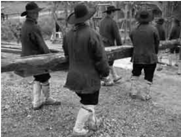
Transport eines Rähms zur Baustelle (Foto: FLMK)
