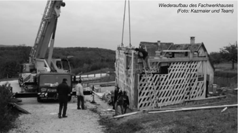
mente für das aufgehende Bauwerk verformungsgetreu hergestellt werden. Anschließend erfolgte das Wiederaufrichten des Fachwerkgebäudes, welches zwischenzeitlich in der Werkstatt restauriert worden war.
