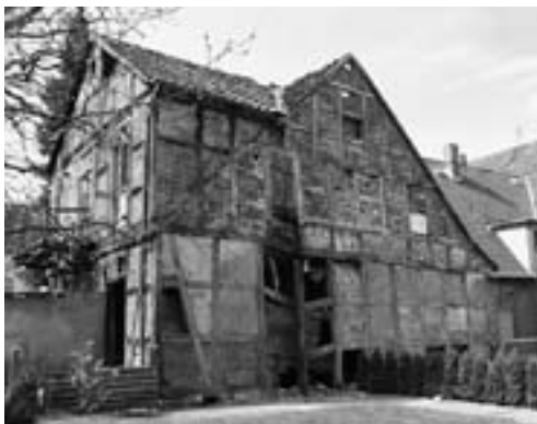
8 Die Ostseite der Scheune: Fachwerk mit Lehmsteinen gefüllt, jüngerer Dachausbau (Foto: Bantz, 2004).
