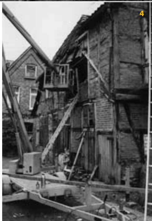
4 Notsicherung am westlichen Dach (Foto: Haase, 2000).
