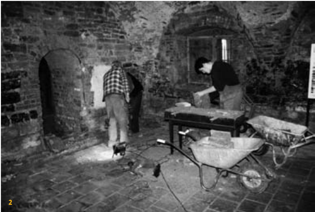
2 Ausbau eines alten Ziegelbodens aus einem Kellergewölbe. (Foto: Leonhardt)
