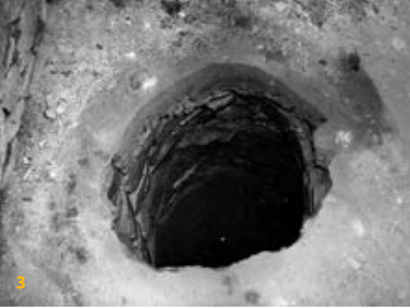
3 Überwölbter Wasserauslauf mit Plattenboden
