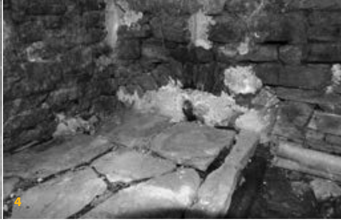
4 Gemauerter Brunnenschacht (Fotos: Kristin Dohmen, LVR-ADR 2013)
