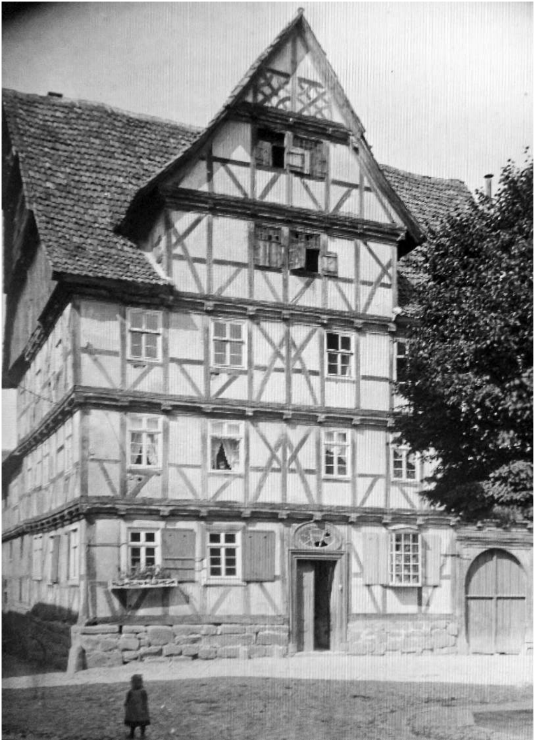
2 Witzenhausen, Kirchplatz 10: Ehemaliges Haus von Malermeister Dietrich (Foto: Staatsarchiv Marburg und Stadtarchiv Witzenhausen)
