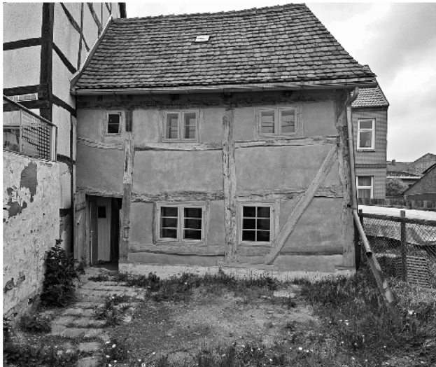
13 / 14 Straßen- und Hoffront nach der Sanierung. Hier zeigt sich deutlich die unterschiedliche Verzimierung – Stockwerksbauweise an der Vorderfront und Ständerbauweise an der Rückfront.
