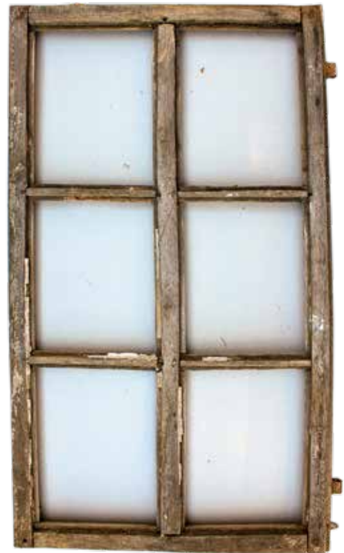
4 Fenster mit Massivholzsprossen um 1870
