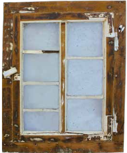
3 Fenster mit Rahmen, Winkelbändern und Mittelsteg um 1790
