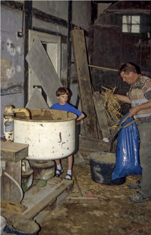
1 Das zweite Leben einer Teigknetmaschine – als Zwangsmischer für die Lehmaufbereitung. Unsere Teigknetmaschine bei der Restaurierung des Museumshauses in Bad Mündler (Foto: Michael Meier)
