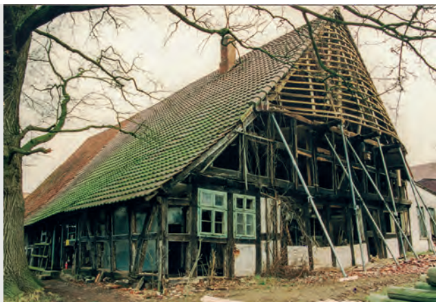
3 Notsicherung des Gartengiebels bei Beginn der Restaurierung (Fotos: privat)
