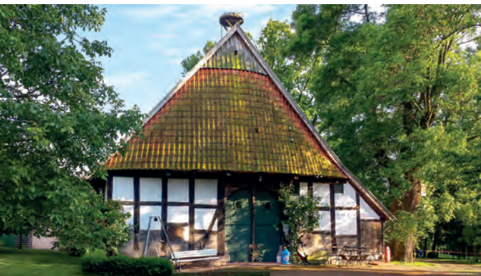
6 Hofgiebel bei Beginn der Restaurierung
