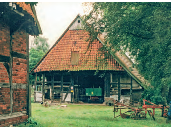
2 Hofgabel vor Übernahme durch den Verein „denk-mal! Windheim No2“
