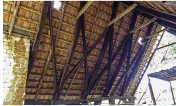
4 Blick auf das Dachwerk des Renaissancehauses. Auf der einen Dachseite wurden gegen Winddruck scharfkantig gesägte Andreaskreuze eingebaut. So etwas hatten wir in unserer Region noch nicht gesehen.
