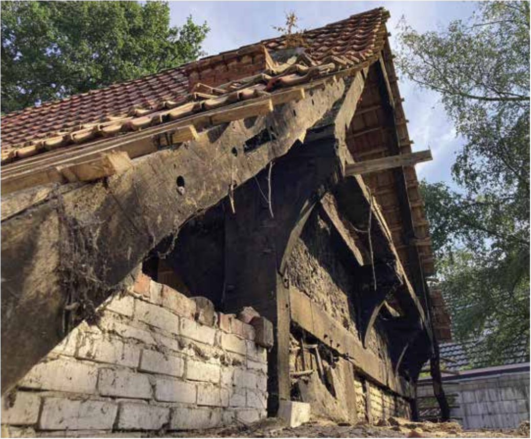
9 Blick auf den hinteren Giebel mit aufgeschobenen Sparren, wie beim Vorschauerbalken mit Spuren von Zweitverwendung. Im Erstzustand war es ein Rähm einer Seitenwand, datiert mit 1604 d. (Foto: Bernd Kunze)
