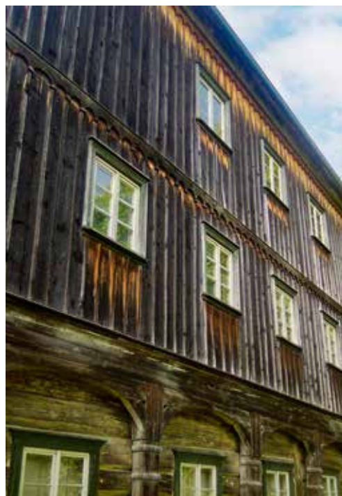
5 Der sanierte und inzwischen stark vergraute Behang auf der Südseite des Hauses
