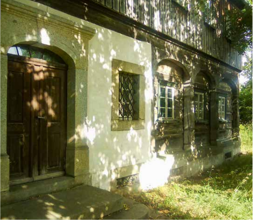
1 Von stattlichen Linden beschattet - „Steinteil“ und Blockstube
