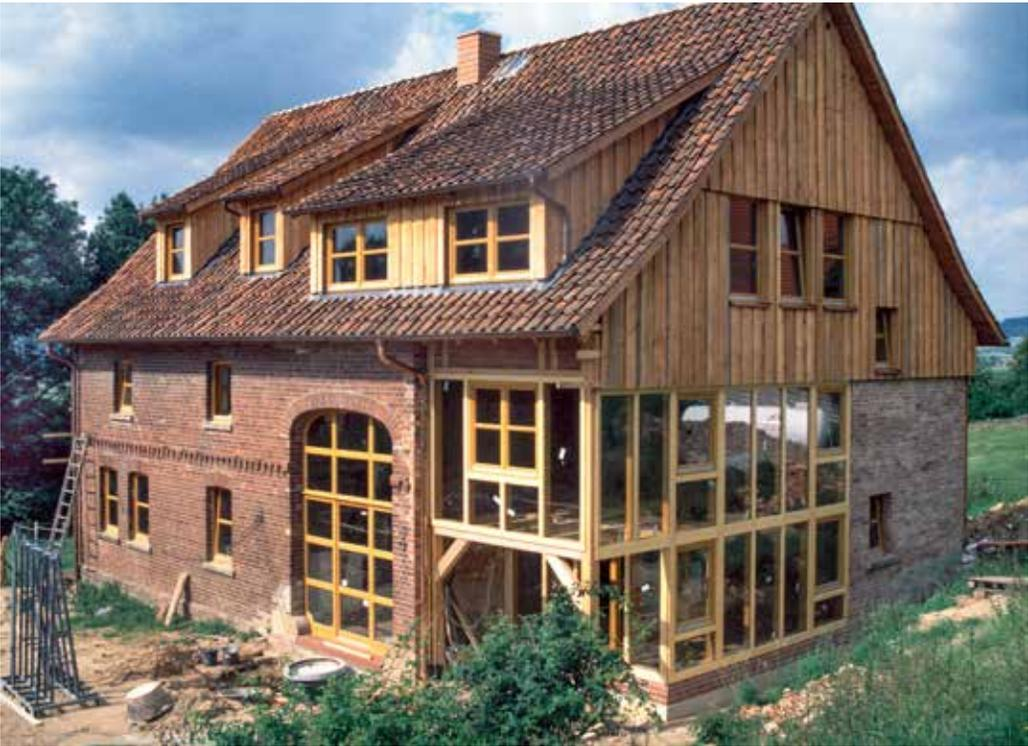
1 *Beispiel für die Nutzung passiver Solarenergie bei Umbau und Sanierung eines Bauernhauses. West- und Nordseite sind außen gedämmt und mit Lärchenholz verkleidet. (Foto: Manfred Röver)*
