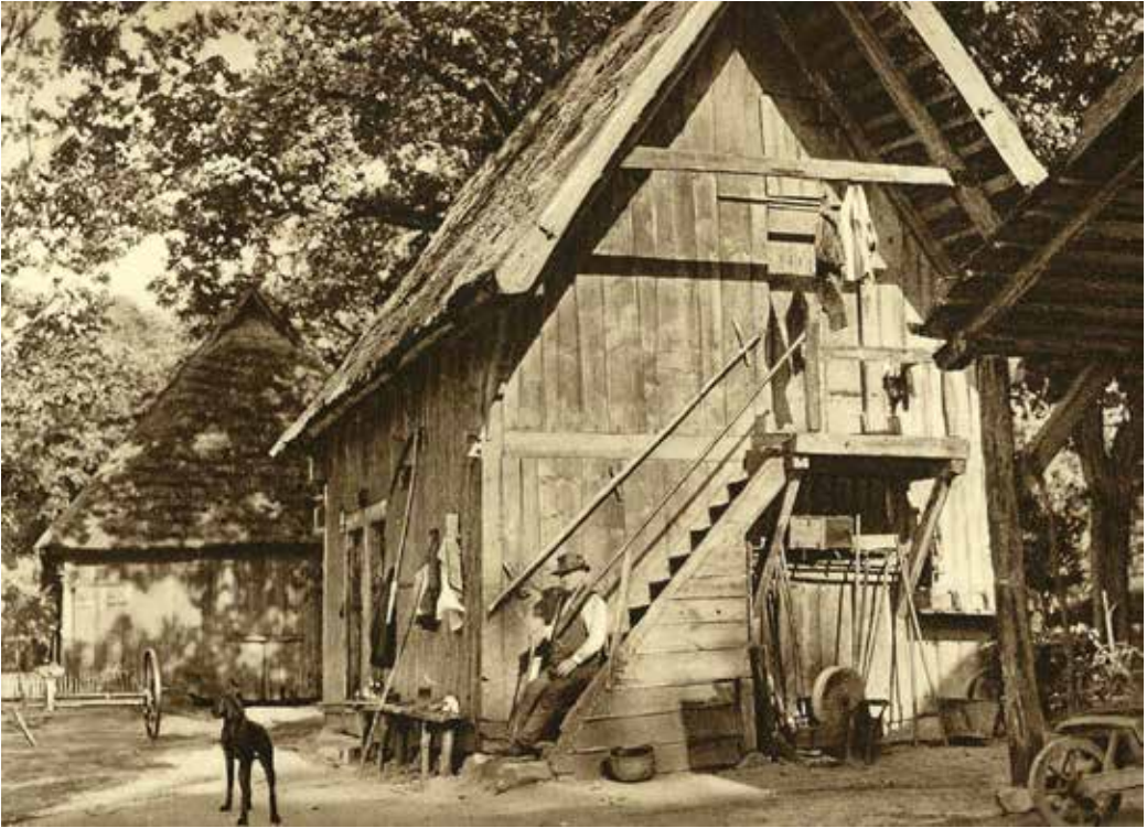
9 Lüneburger Heide, Treppenspeicher und Hofschafstall auf einem großen Hof (Foto: Archiv Museumsdorf Hösseringen)
