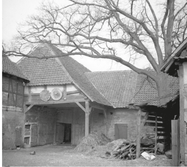
8 Niederdeutsches Hallenhaus in Wendezelle von ca. 1800 mit freistehendem Eckständler (Foto: Landesamt für Denkmalpflege, Fotosammlung)
