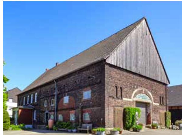
14 1868: niederdeutsches Hallenhaus mit hohem Drempe! über dem Wirtschaftsteil aus unverputztem Backstein in DO-Wickede, Wickeder Hellweg 185. Besonders bemerkenswert ist ein zusätzliches Tor in der straßenseitigen Traufwand, durch das ein Wenden oder Rückwärtsschieben der eingefahrenen Wagen und Karren vermieden wurde (Foto: Verf. 2025)
