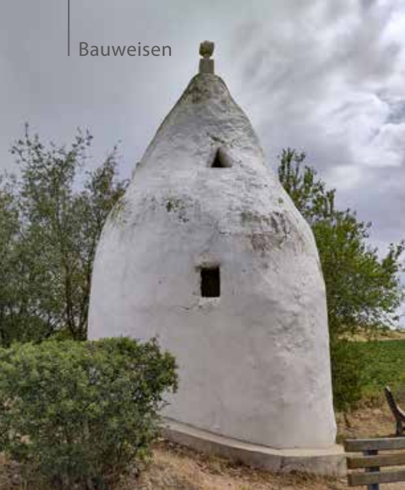
1 Flonheim-Adelsberg: winzige Fensteröffnung und Kuppelöffnung (Foto: Gabriele Höppner, 2025)
