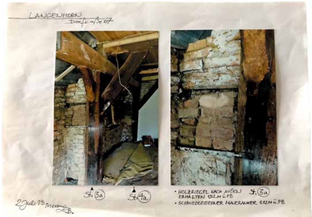
16 Original erhaltene Innenständer Südseite 3a + 4a (Fotos: Ellen Bauer)
