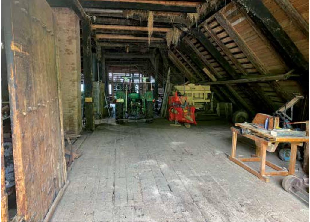
5 Das Dachtragewerk mit rauchgeschwärzten Balken: Firstständerkonstruktion über dem talseitigen Stallteil und liegendem Stuhl über dem Wohnteil (Foto: Andreas Mack)
