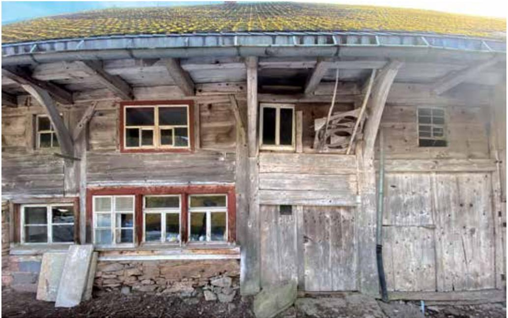
im Erdgeschoss hat sich im rückwärtigen Bereich der Dreschtemenboden erhalten, ebenso die erbaungszeitliche Außenwand des Dreschdenns. Im Dach jedoch fehlen entlang der Überfahrtsbrücke im Dachraum die Dreschtemenwände, sodass dieser Bereich eben nicht für die Funktion des Dreschens vorgesehen war.
