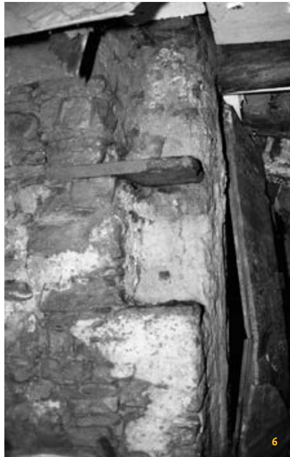
6 Beidseitig befinden sich Nischen in den Türleibungen
