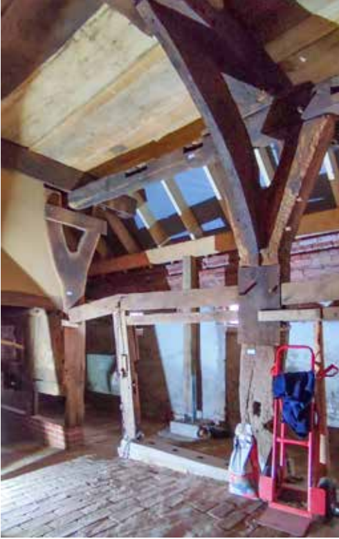
19 Talge (Lkr. Osnabrück), Hof Rottmann („Rottmes Hus“). Das Zweiständer-Innengerüst mit Gabelständern von 1428 (d) ist das derzeit älteste Hallenhausgerüst in Deutschland. Es wurde mindestens zweimal umgesetzt oder neu abgezimmert und verbirgt sich hinter einem Artländer Knaggengiebel von 1820. (Foto: Stiewe 2022)
