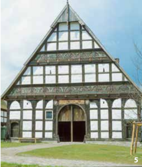
5 Der Valepagenhof aus Delbrück, heute im LWL-Freilichtmuseum Detmold: Der prächtige Vierständerbau mit Fächerrosetten am Giebel wurde 1577 von Joist Valepage als ländlicher Adelssitz erbaut. (Foto: G. Ulrich Großmann 1981, LWL-FM Detmold)
