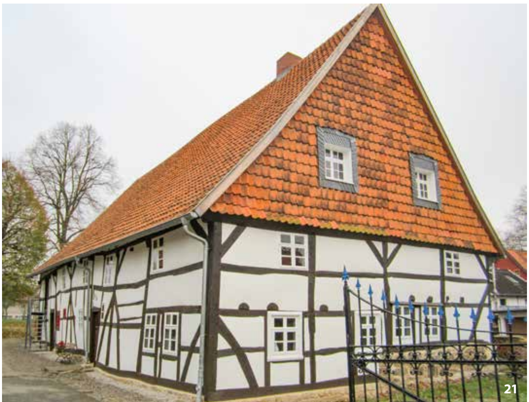
21 Wallenstedt (Lkr. Hildesheim), „Brunottescher Hof“. Vierständerbau ohne Einfahrtstor, 1594 (d), Blick auf das Kammerfach. Das Haus wurde von einem örtlichen Verein vor dem Abriss gerettet und restauriert. (Foto: Andreas Formann, 2014)
