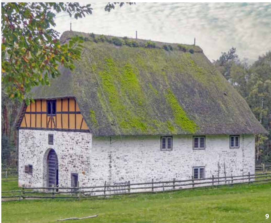
9 Hallenhaus mit Bruchsteinaußenwänden von 1724 aus Rhinschen-Schmidthausen (Kierspe, Märkischer Kreis) im LVR-Freilichtmuseum Kommern (Foto: Stiewe 2017)
