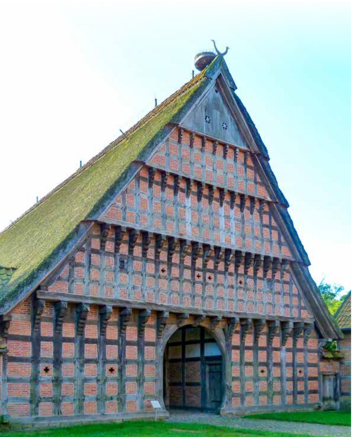
1 Hof Wehlburg aus Wehdel im Artland (Lkr. Osnabrück), heute im Museumsdorf Cloppenburg. Mit ihrem prächtigen, vierfach vorkragenden Knaggengiebel gilt die „Wehlburg“ als berühmtestes Niederdeutsches Hallenhaus. (Foto: Michael Schimek, Museumsdorf Cloppenburg)
