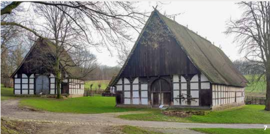
8 Rechte Seite oben: Godelheim (Kr. Höxter), Karlshafener Straße 8-12 (von rechts nach links). Dörfliche Vierständerhäuser von 1840 und 1849 mit Brettergiebeln, Haus Nr. 12 (rechts) aus der Zeit um 1600, noch mit Sollingplattendeckung (Foto: Stiewe 2022)
