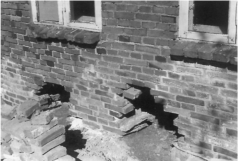
*Trockenlegung im Wechsel mit gleichzeitiger Nachgründung und Mauerwerksausbesserung
