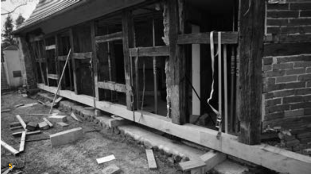
4 Die neue Schwelle kommt an ihren Platz.
