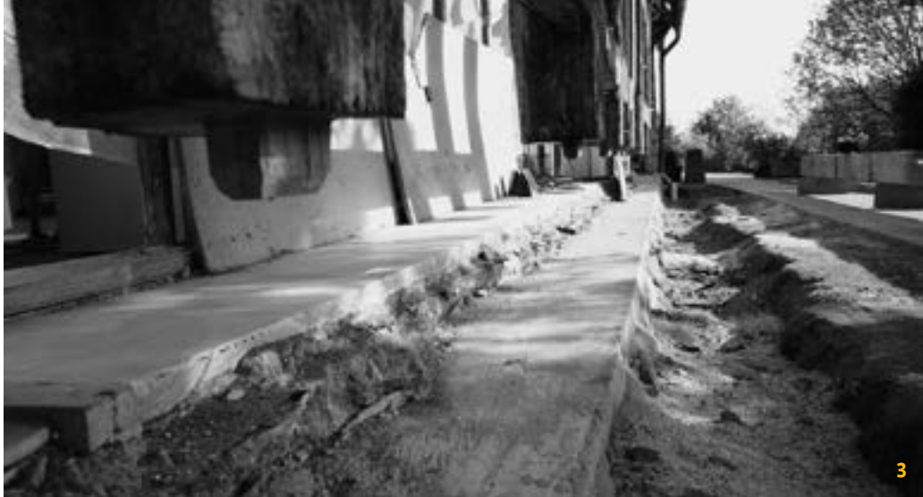
3 Die frisch geschnittenen Zapfen warten auf die Schwelle.
