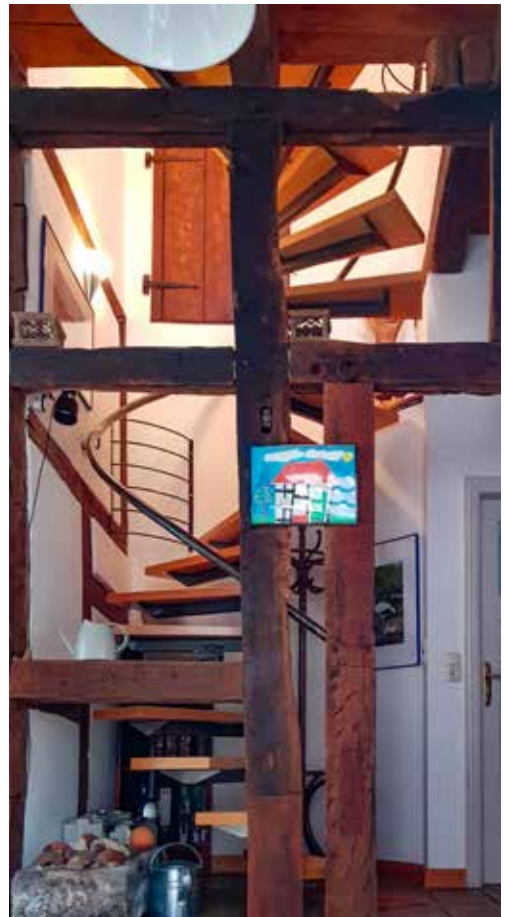
11 Aus Platzgründen wurde eine Wendeltreppe zum Dachgeschoss gewählt, die sich gut hinter dem offenen Fachwerk einfügt. (Fotos: Alfons Rolf Bense)
