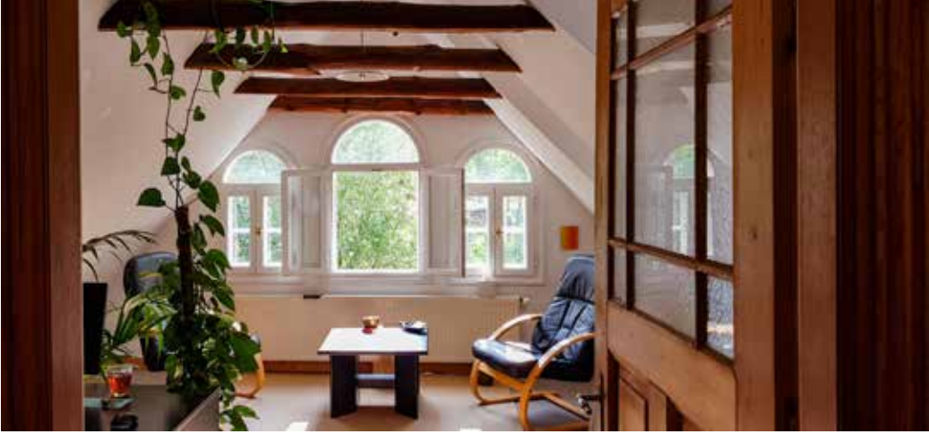
12 Einer der beiden Gesprächsräume im Dachgeschoss mit den sichtbar gebliebenen Kehlbalken. Beim Ausbau 1993-1995 entstanden die neuen Fensteröffnungen. (Fotos: Alfons Rolf Bense)
