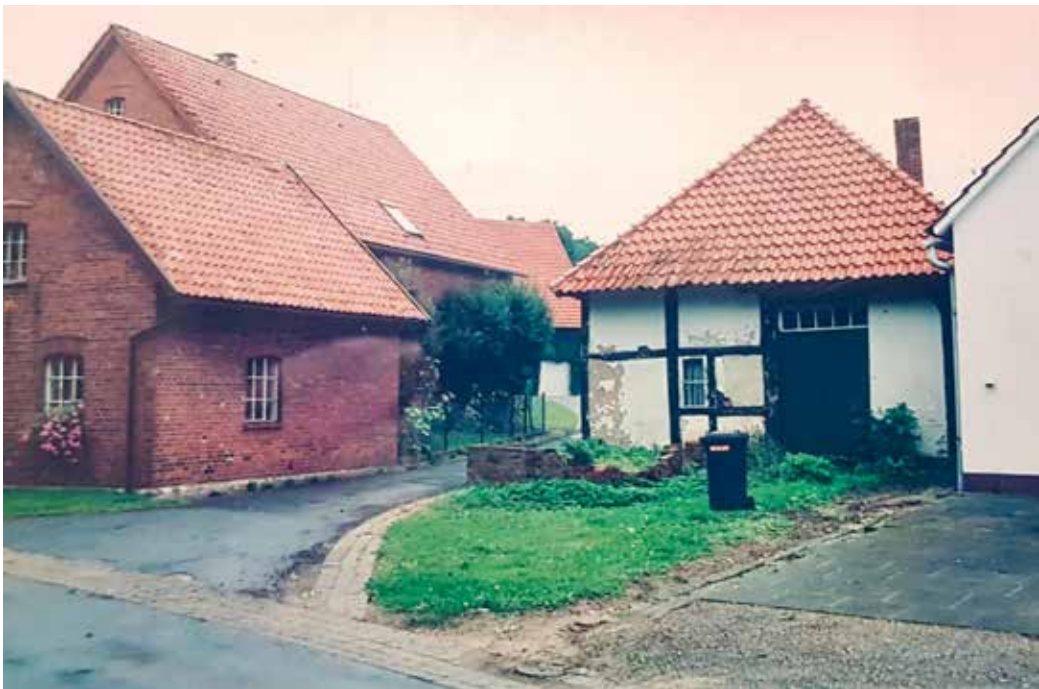
5 Zustand des Hauses Unter den Weiden 5 im Jahr 1993. Flacher untypischer Notwalm nach Kriegseinwirkung; Tor verbaut, Torgebälk nur unvollständig erhalten (Foto: Alfons Rolf Bense)
