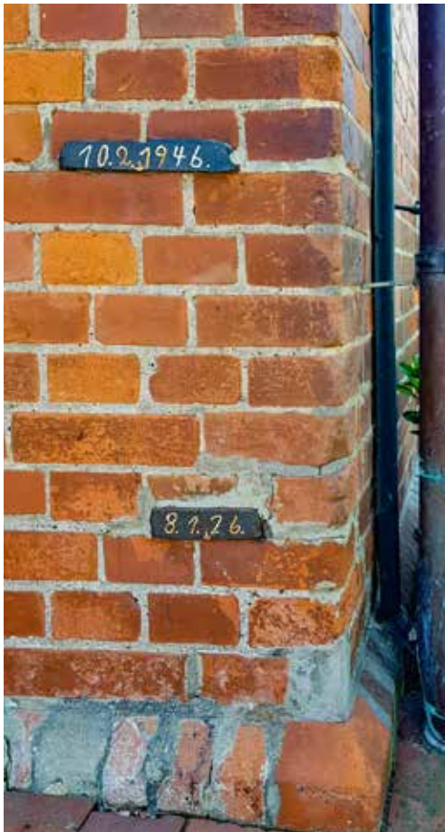
10 Hochwassermarken an benachbarter ehemaliger Schmiede Kuhlmann
