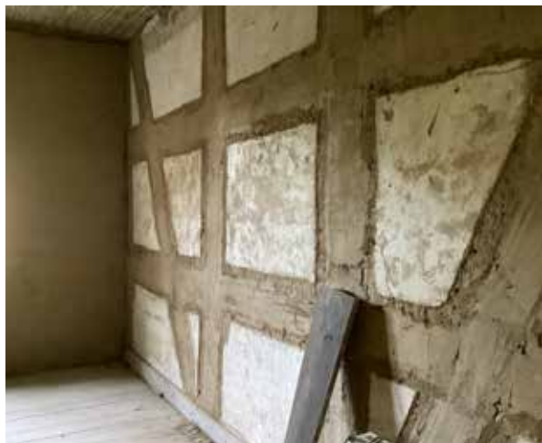
3 Zwischenstand Lehmarbeiten im 1. Obergeschoss – Fachwerk mit Putzträger und erster Lehm-schicht bedeckt
