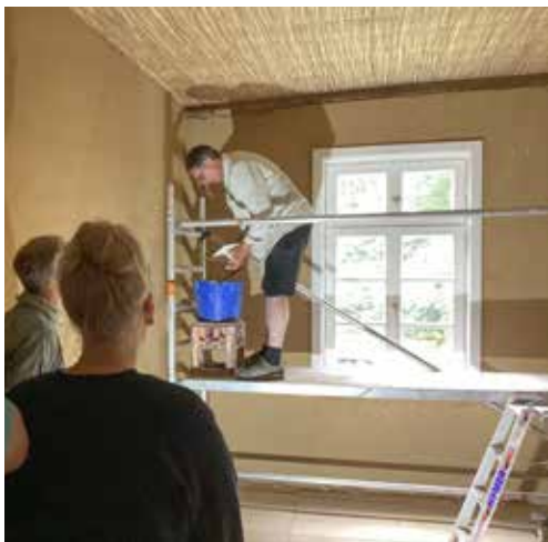
2 Unser Anleiter Michael zeigt das richtige Auftragen des feuchtflüssigen Lehms an der Zimmerdecke
