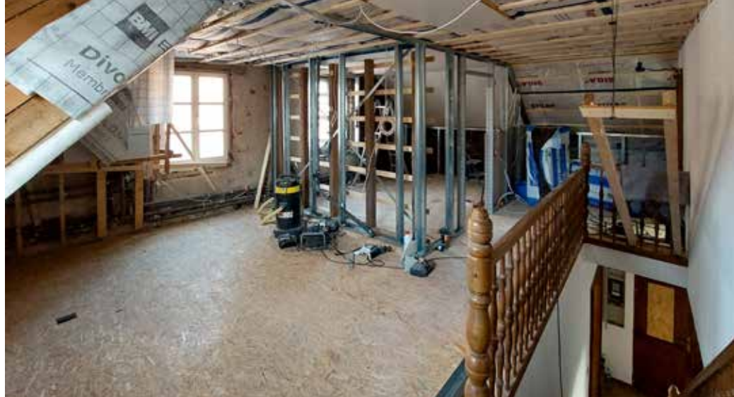
9 Das Obergeschoss während seines Wiederaufbaus, der aufgrund des Wasserschadens erforderlich wurde (Foto: Lutz Kühnen)
