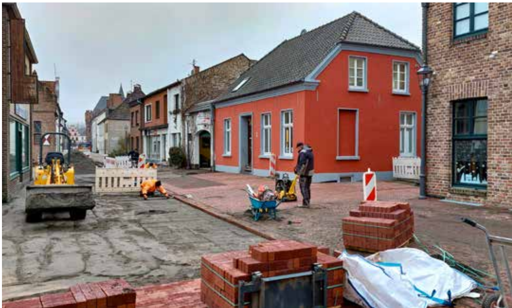
8 Das fertig sanierte und frisch gestrichene Baudenkmal strahlt. Auch die Erneuerung der Straße ist inzwischen abgeschlossen (Fotos: Lutz Kühnen)
