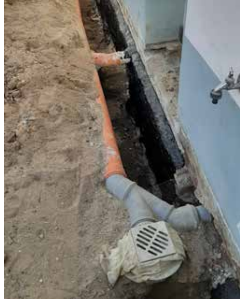
5 Zu sehen ist der teilweise noch offene Graben auf der Rückseite des Gebäudes. Das gemauerte Streifenfundament wurde gereinigt, neu verputzt und abgedichtet sowie die Abwasserleitungen erneuert (Foto: Lutz Kühnen)
