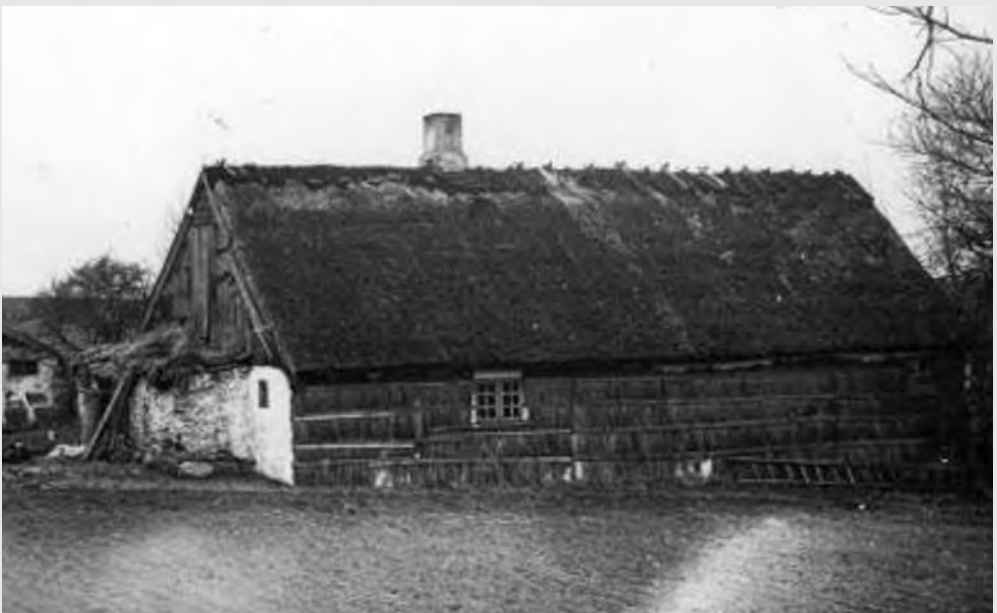
12 Bauernhaus in Süddänemark mit behängener Längsseite (Quelle: Bildautor A. Steensberg 1939, Dänisches Nationalmuseum Kopenhagen)
