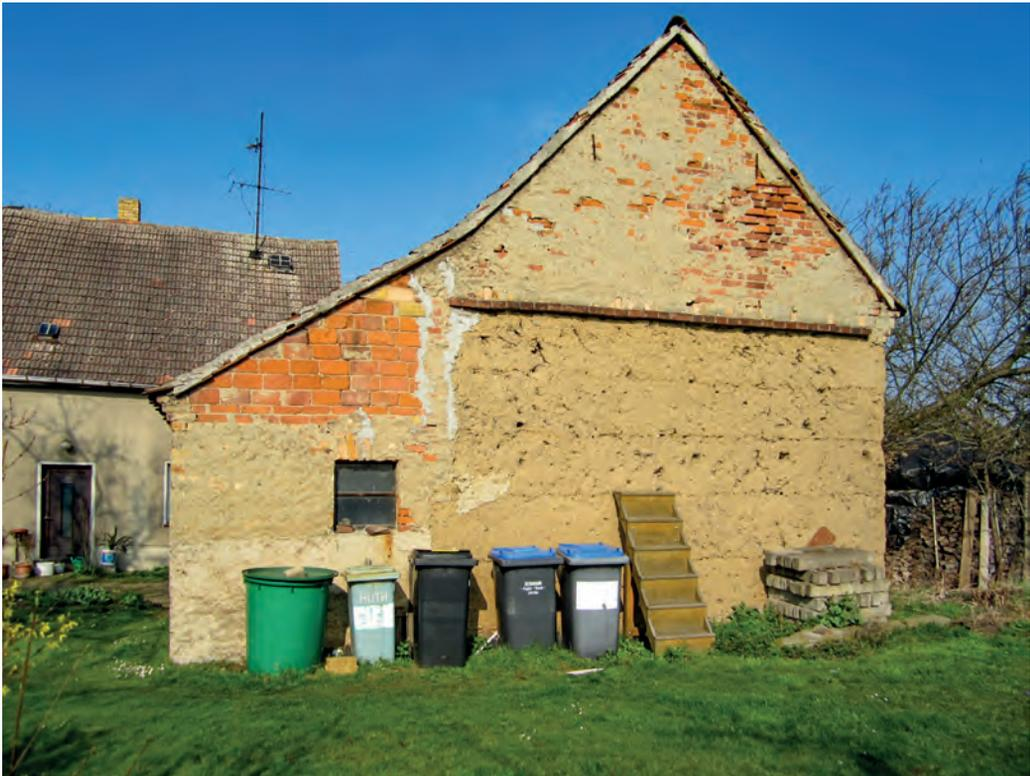
9 Kossaer Straße 17: Stallaufbau in fünf Arbeitsgängen, oberer Teil aus Ziegeln. In der Wand wurden später Rohre als Belüftungslöcher eingebaut. (Foto: Philipp Kristin 2015)
