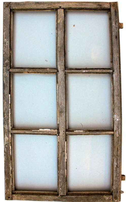
4 Fenster mit Massivholzsprossen um 1870
