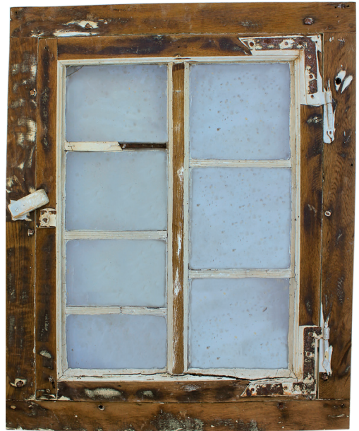
3 Fenster mit Rahmen, Winkelbändern und Mittels-teg um 1790
